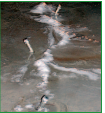
Rozwarcia rys HA Flex AF: >4mm HA Flex LV AF: 0,5-4mm HA Flex SLV AF: <0,5mm
