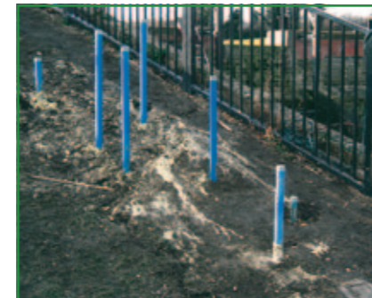
Wzmacniania i stabilizacji gruntu
